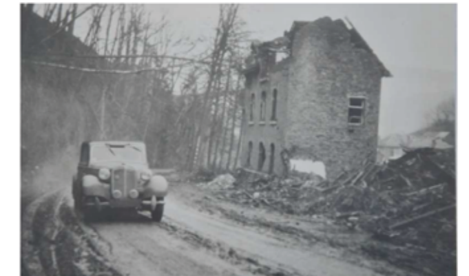
A droite de la photo, près de la bâtisse en ruine, tout ce qui restait de la maison familiale de Jeanne Simon !
